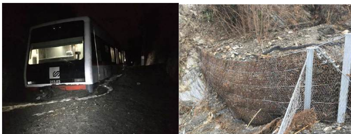
Figura 6. Convoy enterrado en escombros y vista barrera embudo colmatada.
