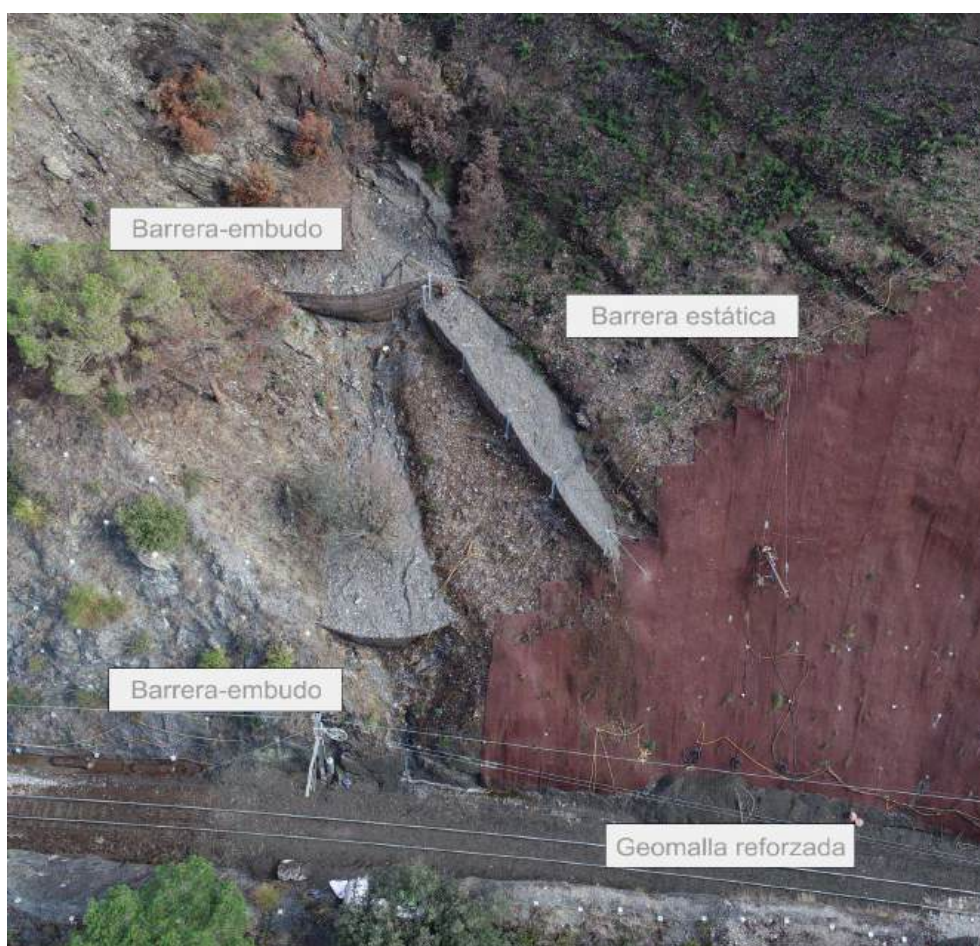
Figura 7. Vista de las barreras embudo y estática colmatadas de material tras el episodio de lluvias torrenciales del 22 de octubre de 2019. Talud geomalla reforzada.
