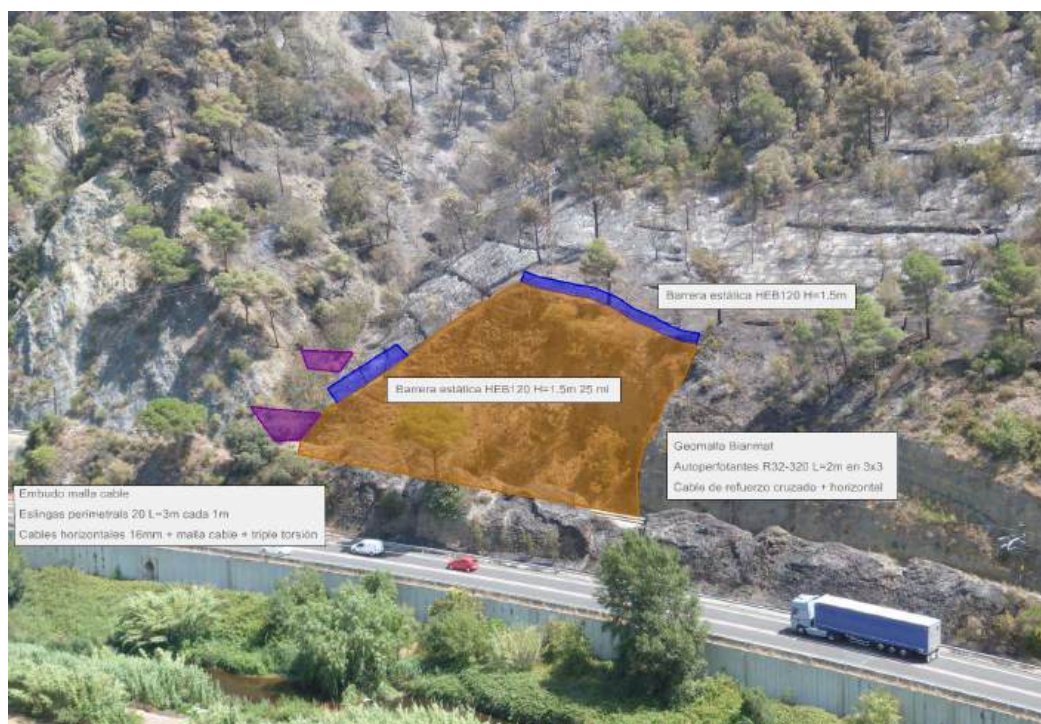
Figura 5. Situación de barreras embudo, barreras estáticas y geomalla reforzada en el talud.
