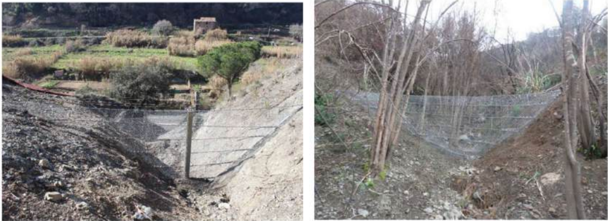
Figura 9. Barreras flexibles tipo embudo instaladas en el eje del barranco en la parte baja de la ladera
