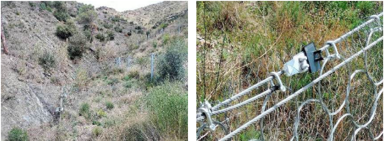
Figura 12. Dispositivos de monitorización en las estructuras instaladas en el barranco. a) Sistema de detección automática aspa-flecha en las barreras embudo b) Dispositivo Guard de Geobrugg instalado en la barrera debris
