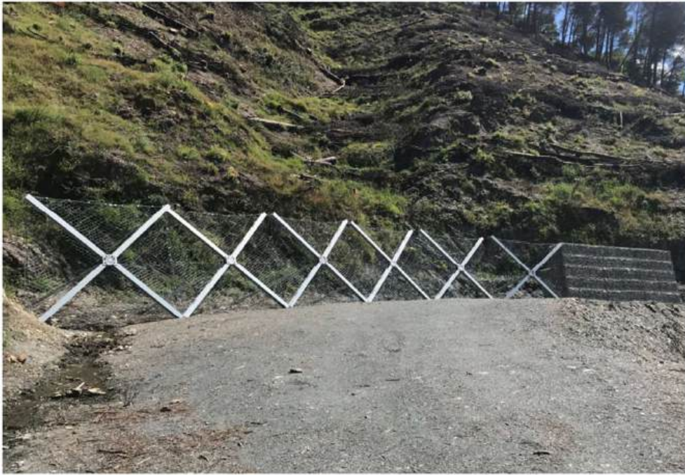
Figura 11. Barrera con estructuras Erdox y cierre con muro de gaviones en la pista forestal para conducir el curso del torrente
