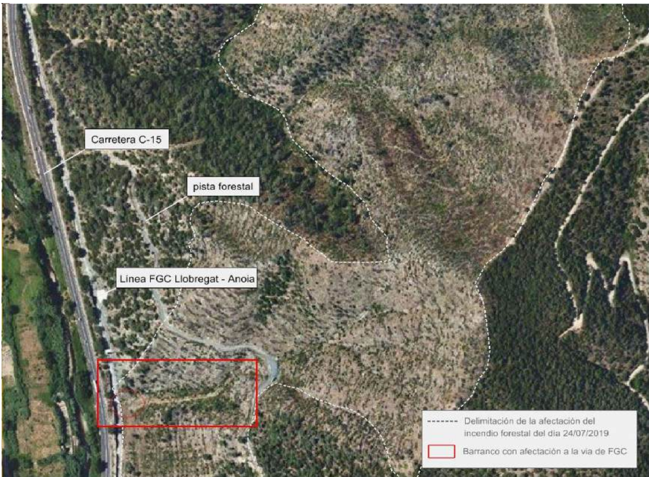
Figura 1. Fotografía obtenida con vuelo dron de la ladera incendiada, torrentera e infraestructura ferroviaria FGC y carretera C-15.
